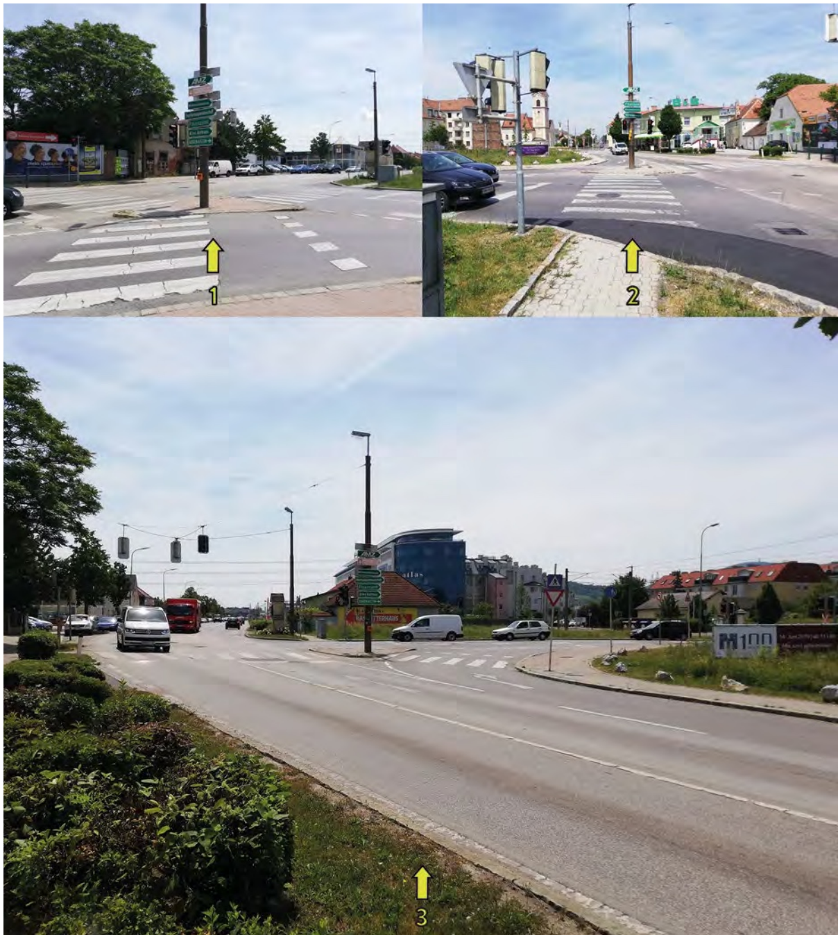
ABBILDUNG 67: Detaillierte Darstellung der Situation an der Stelle Wiener Neudorf – Einmündung Schillerstraße in die Triester Straße (Fotos: KfV)
