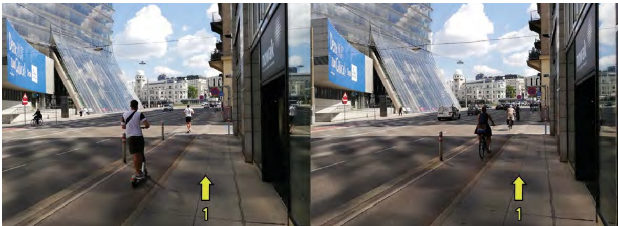
ABBILDUNG 40: Detaillierte Darstellung der Situation an der Stelle Ferdinandstraße & Aspernbrückengasse (Fotos: KfV)
