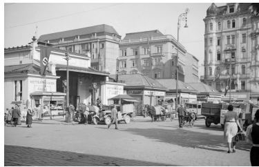
Stadtbahnstation Kettenbrückengasse in der Zeit des Nationalsozialismus, 1939 (Foto: unbekannt), ÖNB-Bildarchiv / picturedesk.com
